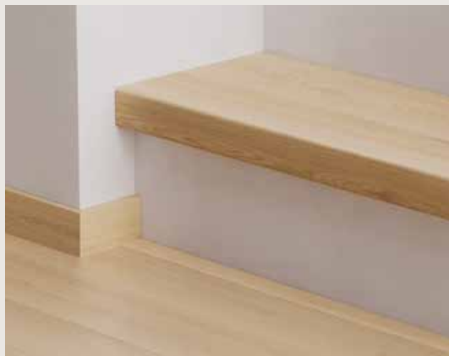
INSTALACIÓN DE CONTRAHUELLAS PINTADAS Instale solo los peldaños y pinte el resto en el mismo color que la pared.
